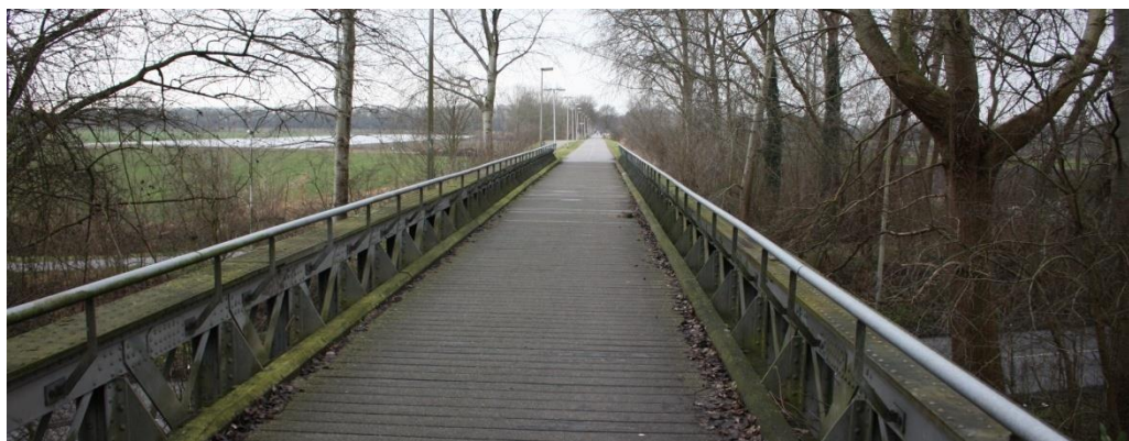
Figuur 10: Bestaande Spoorbrug
