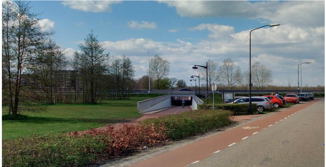
Figuur 1: Tunnelbak N261
