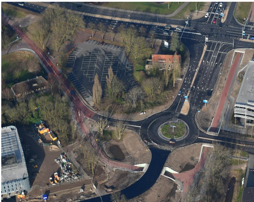
Figuur 34: luchtfoto januari 2018: Rotonde Deutersestraat – Vlijmenseweg met 2 tunnelbakken
